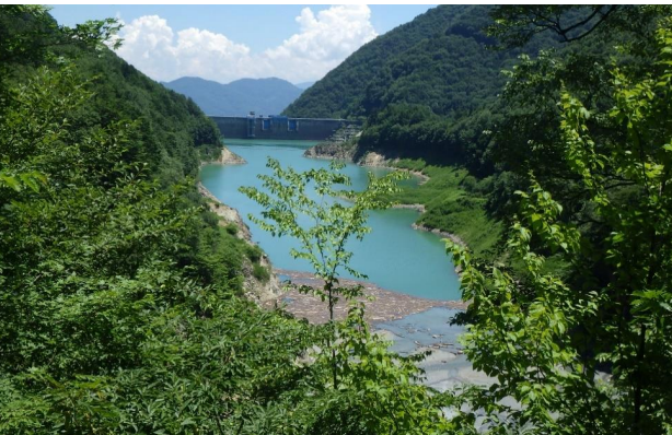
定点5 北葛沢覆道
