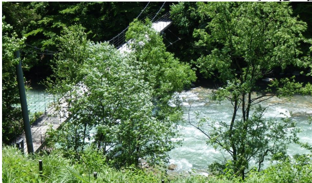
泉小太郎吊り橋
