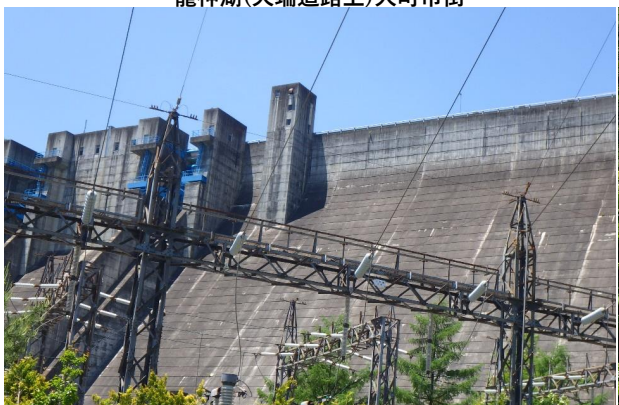
下流公園から大町ダム
