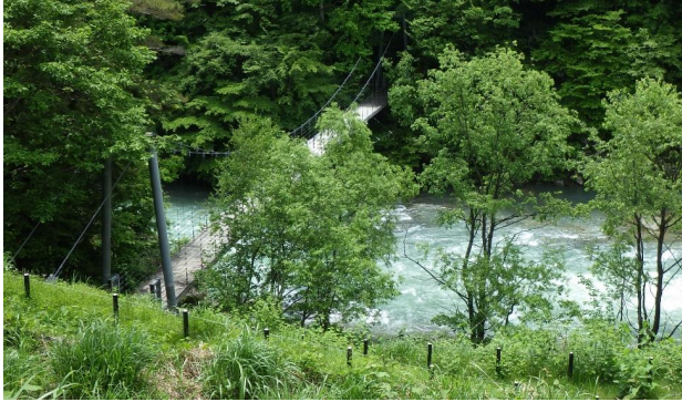
泉小太郎吊り橋
