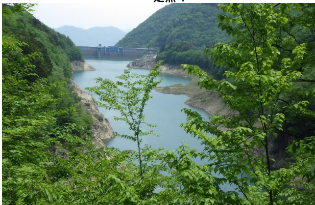
定点5 北葛沢覆道
