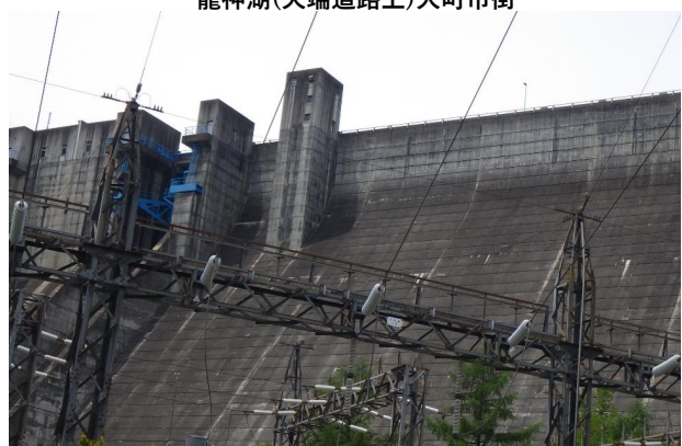
下流公園から大町ダム
