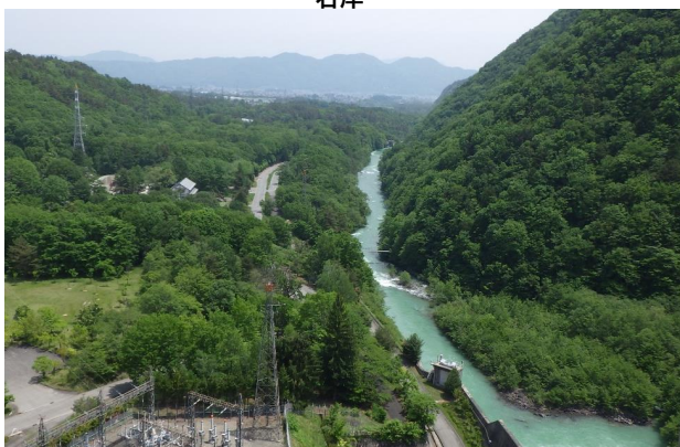
龍神湖(天端道路上)大町市街
