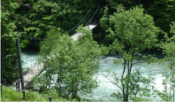
泉小太郎吊り橋
