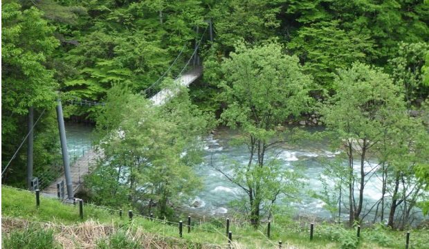
泉小太郎吊り橋
