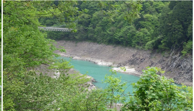
金沢広場の中ノ沢吊り橋
