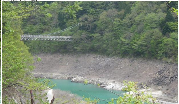
金沢広場の中ノ沢吊り橋
