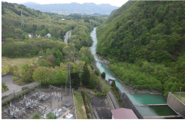
龍神湖(天端道路上)大町市街
