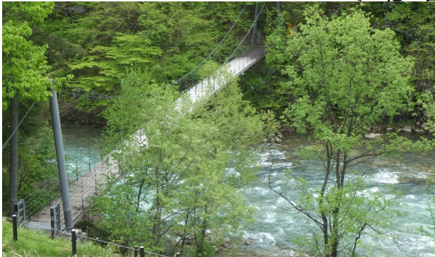
泉小太郎吊り橋
