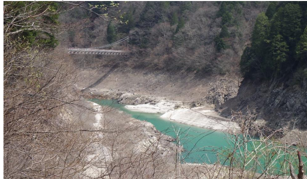
金沢広場の中ノ沢吊り橋
