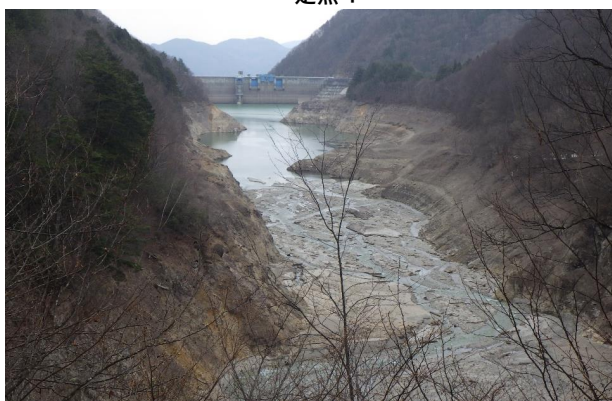
定点5 北葛沢覆道
