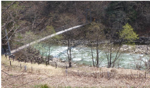
泉小太郎吊り橋
