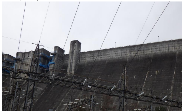
下流公園から大町ダム
