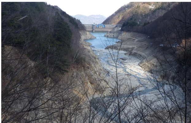
定点5 北葛沢覆道
