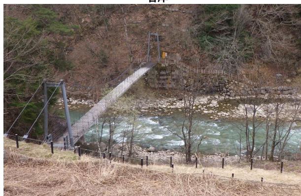
泉小太郎吊り橋
