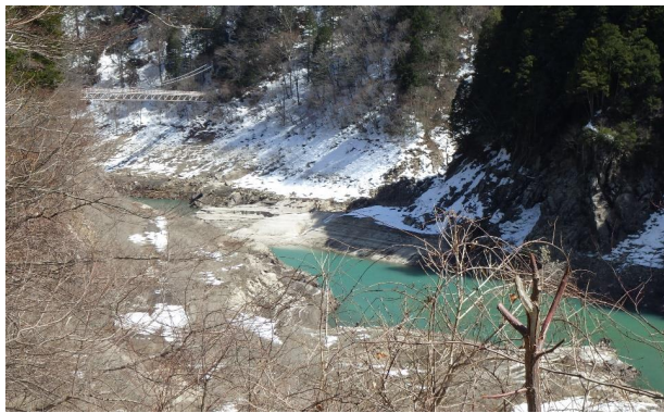
金沢広場の中ノ沢吊り橋
