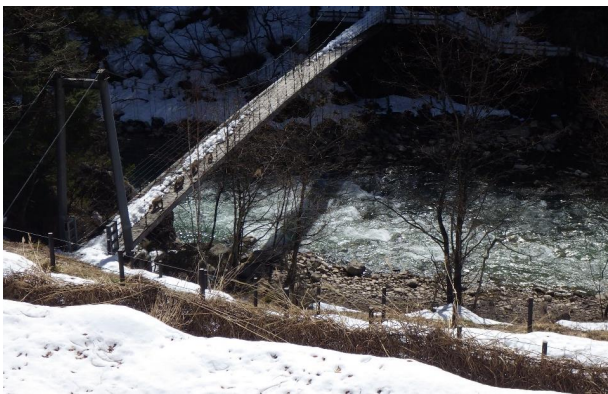
泉小太郎吊り橋
