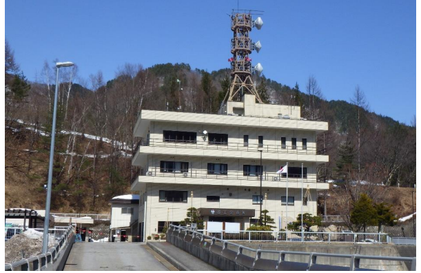
大町ダム管理所
