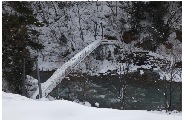
泉小太郎吊り橋
