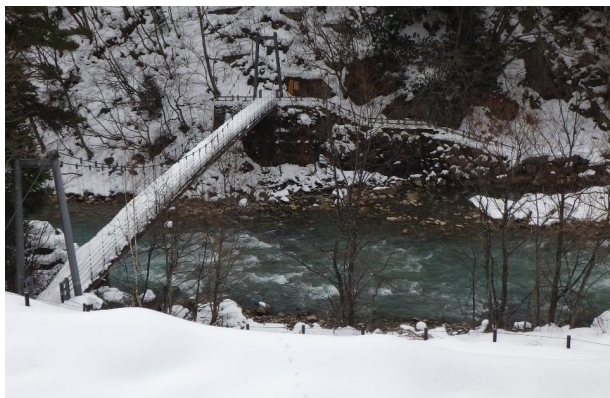
泉小太郎吊り橋
