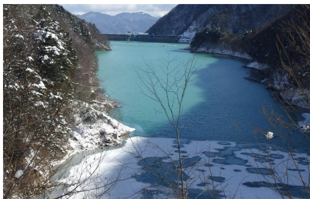
定点5 北葛沢覆道
