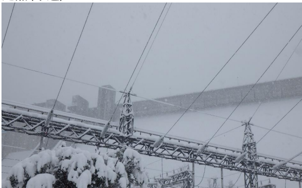
下流公園から大町ダム
