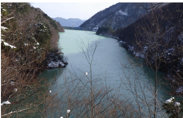
定点5 北葛沢覆道
