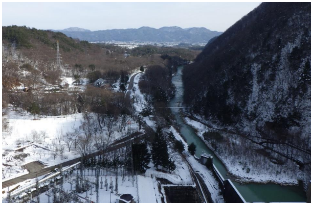
龍神湖(天端道路上)大町市街
