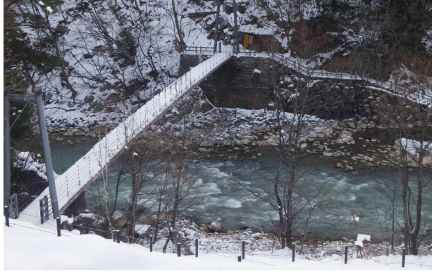
泉小太郎吊り橋
