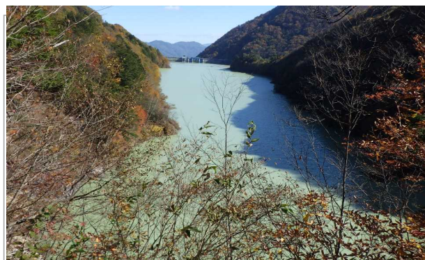
定点5 北葛沢覆道
