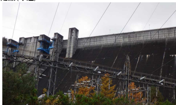
下流公園から大町ダム
