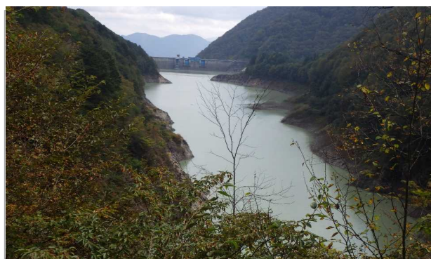
定点5 北葛沢覆道
