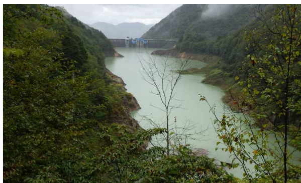
定点5 北葛沢覆道
