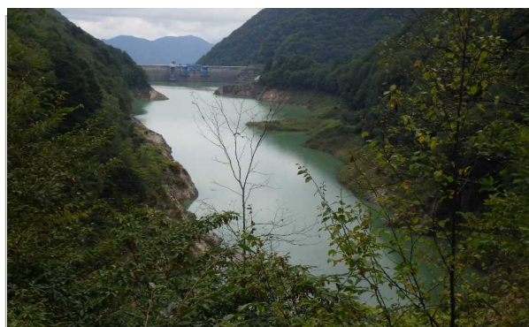
定点5 北葛沢覆道
