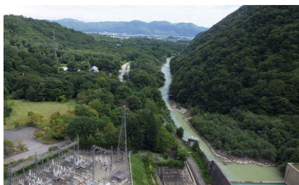
龍神湖(天端道路上)大町市街
