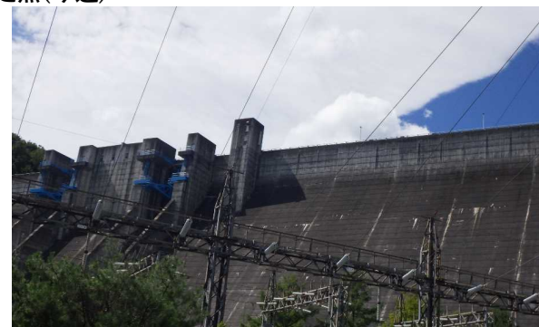
ダム下公園から大町ダム
