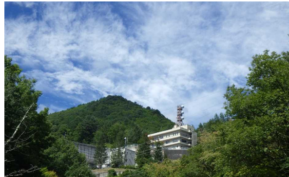
下流公園から大町ダム管理所
