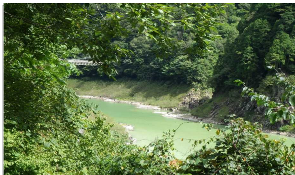
金沢広場の中ノ沢吊り橋
