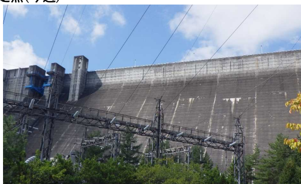
ダム下公園から大町ダム
