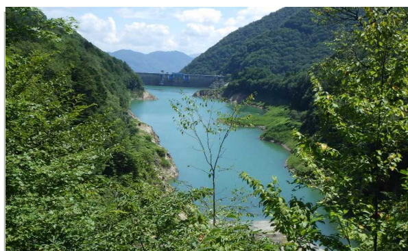
定点5 北葛沢覆道
