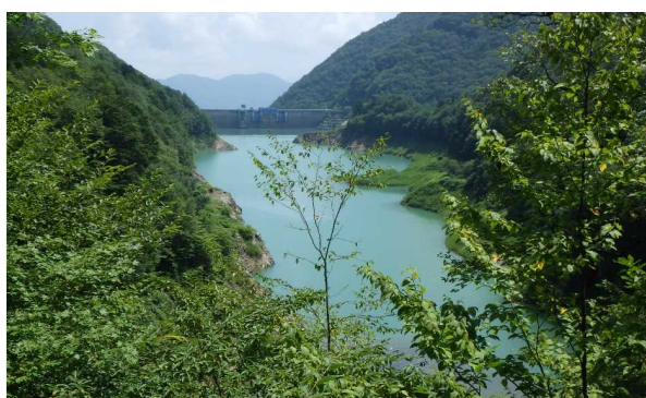
定点5 北葛沢覆道
