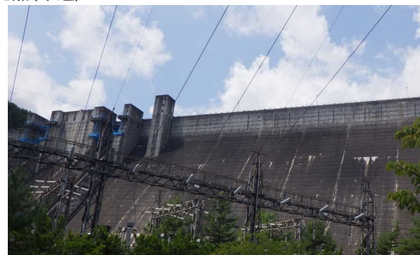
ダム下公園から大町ダム
