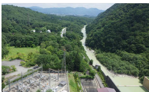
龍神湖(天端道路上)大町市街
