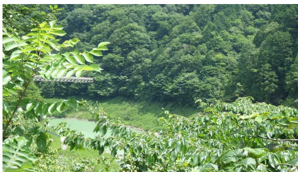
金沢広場の中ノ沢吊り橋
