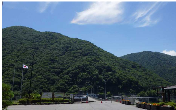
天端道路入口
