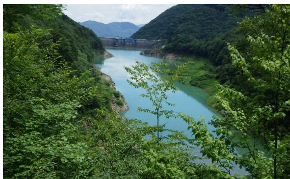
定点5 北葛沢覆道
