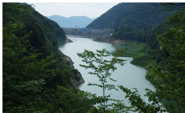
定点5 北葛沢覆道
