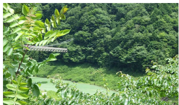
金沢広場の中ノ沢吊り橋
