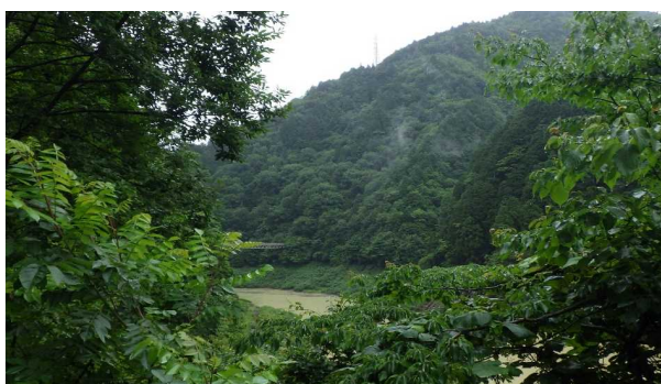
金沢広場の中ノ沢吊り橋
