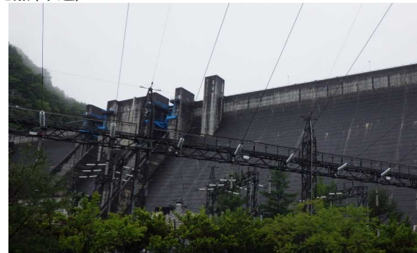
ダム下公園から大町ダム
