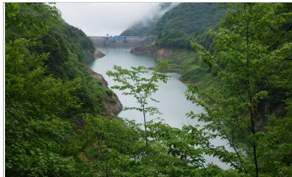
定点5 北葛沢覆道
