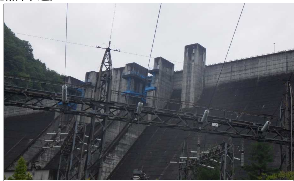
ダム下公園から大町ダム
