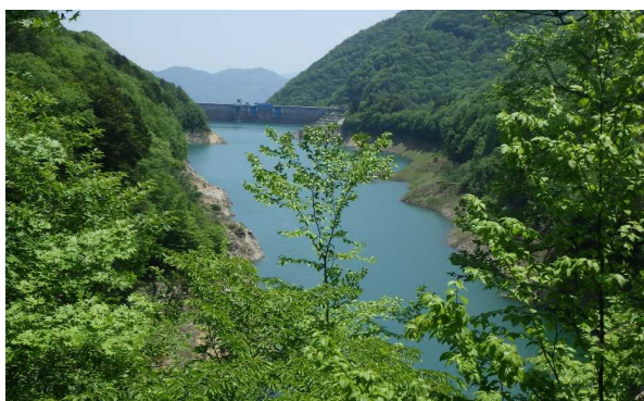
定点5 北葛沢覆道
