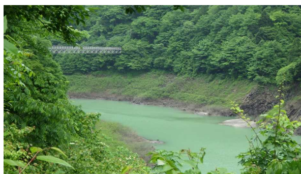
金沢広場の中ノ沢吊り橋
