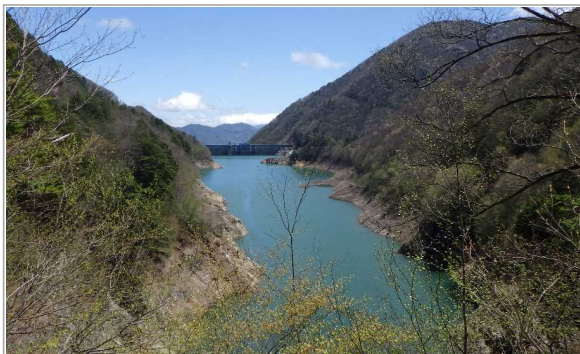
定点5 北葛沢覆道
