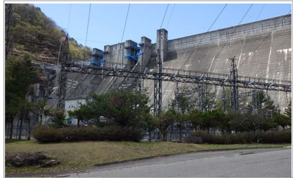
ダム下公園から大町ダム
