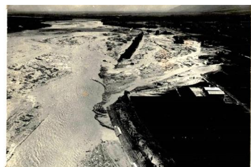
堤防決壊の様子（松川村道の駅から約400m上流部）
