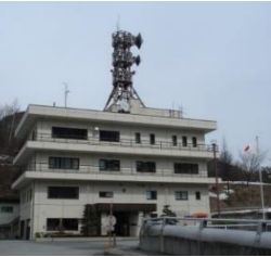
大町ダム管理所
