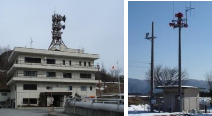
大町ダム管理所
