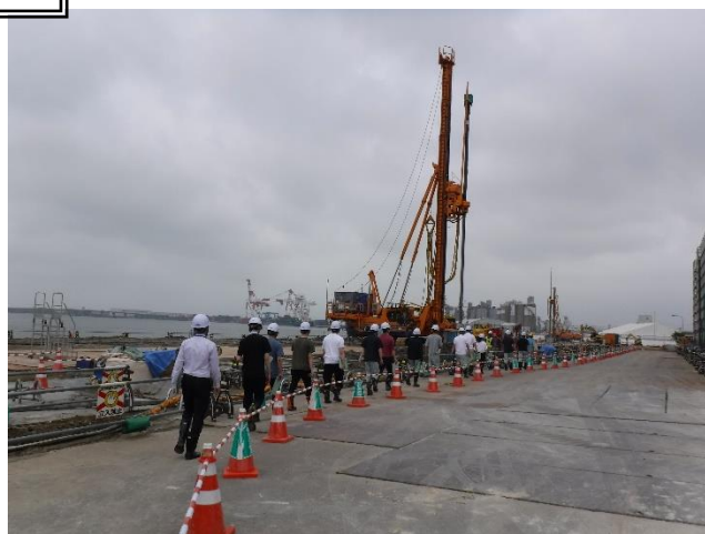
港湾内での大型施工機械を使用した改良工事
