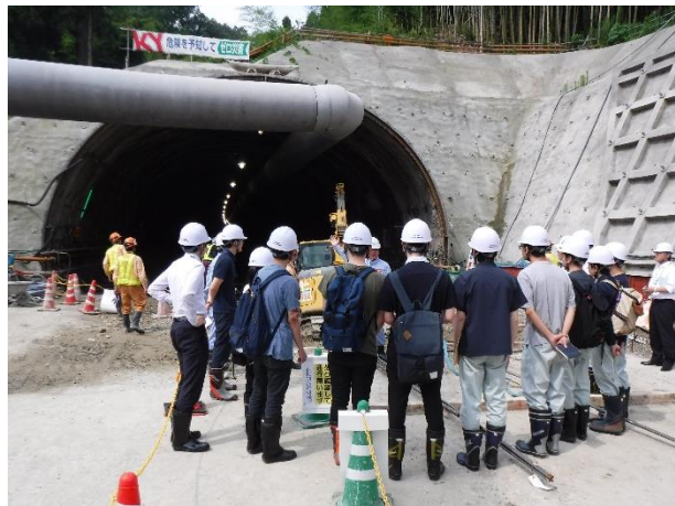
迫力ある大規模トンネル工事を目前で体感
