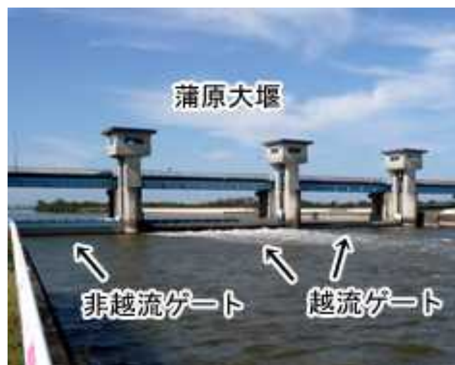
越流ゲートと非越流ゲートにより水量を調節する蒲原大堰（三条市）
