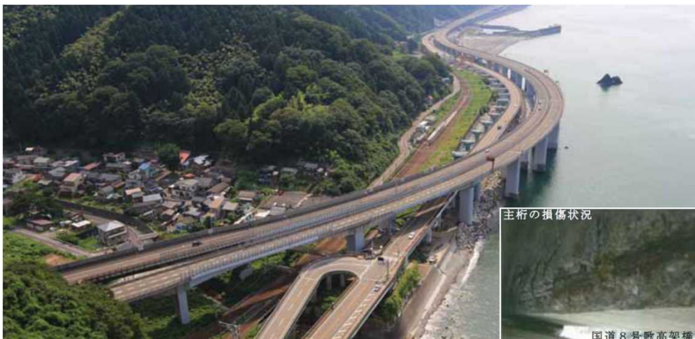
日本海の荒波による影響を受け、塩害による損傷が著しい橋梁の架け替え事業 (糸魚川市)
