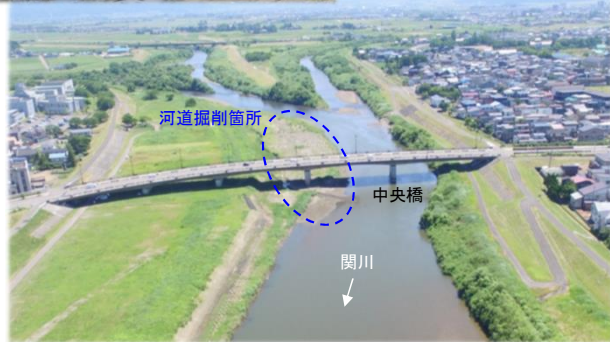
一級河川関川における河道掘削工事(鴨島地区)
