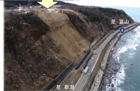
国道8号における災害復旧工事(茶屋ヶ原地区)
