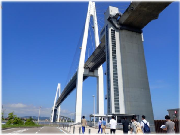
[大規模な土木施設の見学]
