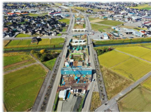
[国道8号 六家立体]
