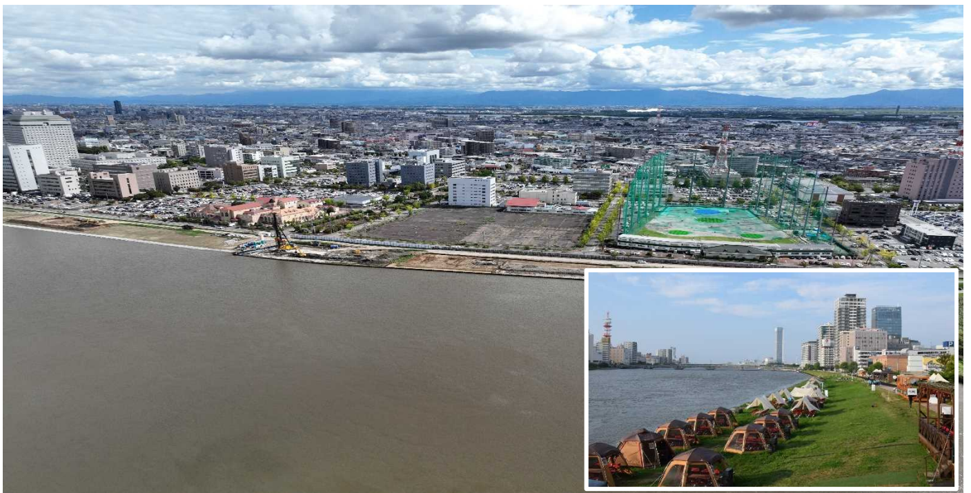
堤防の整備を行い、防災面はもちろん人々が集い、憩える街なかのやすらぎの場を提供
