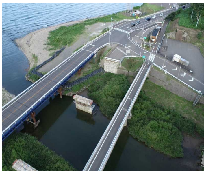
最先端技術BIM/CIMを用いた現場施工：有間川橋（上越市）
