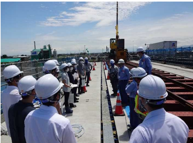
道路拡幅工事現場の見学
