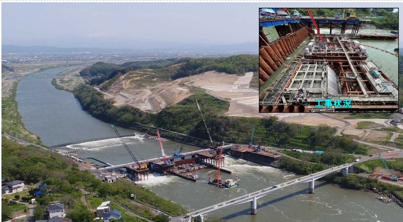
最先端技術BIM/CIMを駆使し挑む、令和の大改修 大河津分水路（長岡市・燕市）
