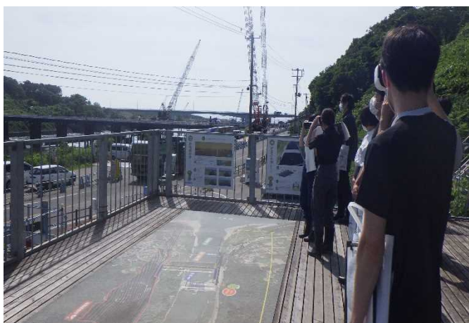
令和の大改修である大河津分水路の工事
