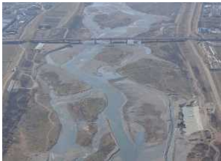
庄川災害復旧工事現場の見学
