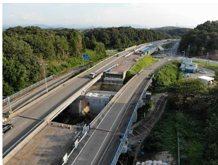
北陸の活力を支える、4車線化事業で、橋梁上部工を 実施中の小松バイパス（小松市）
