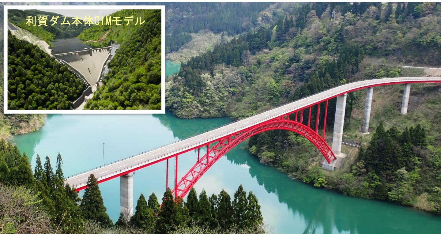
北陸の未来を守る、大規模ダム事業（南砺市）
