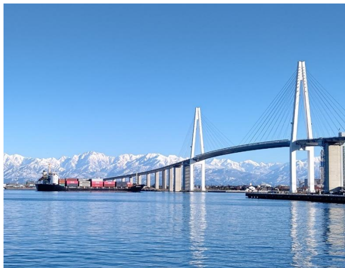
地域経済発展を支える、港湾施設【新湊大橋】（射水市）
