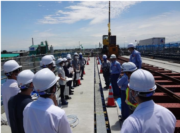
道路拡幅工事現場の見学
