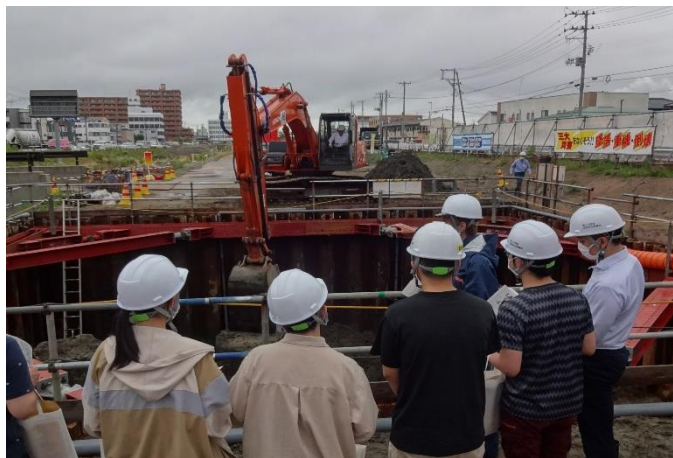
大規模道路改築現場の見学
