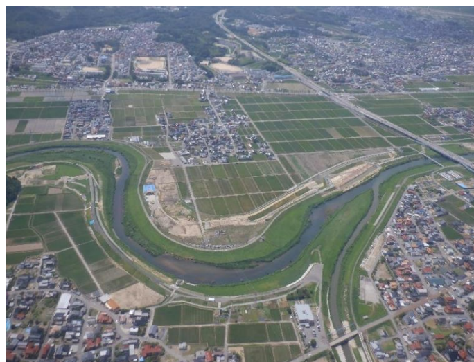
地域の安全を守る、梯川の引堤事業（小松市）
