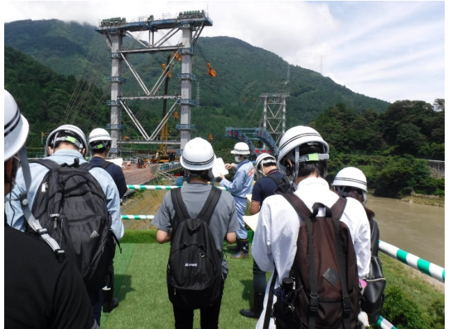
大規模橋梁架設現場の見学
