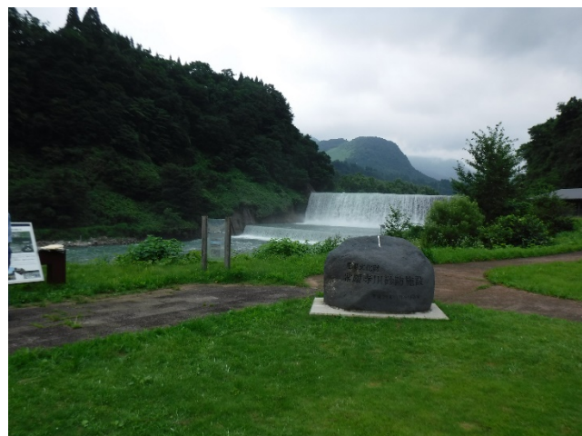
重要文化財に指定された砂防堰堤を見学
