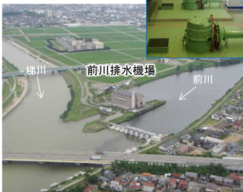
洪水時に前川流域に溜まった水を梯川に排水させ 家屋等の浸水を防ぐ前川排水機場 (小松市)
