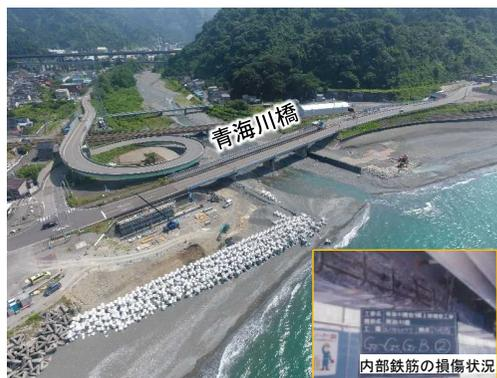
日本海の荒波による影響を受け、塩害による損傷が著しい
