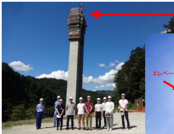
山間部で建設中の高さ約80mの橋脚
