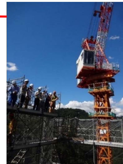
地上から約80mにある橋脚の上まで登りました。
