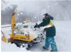
除雪作業実習
